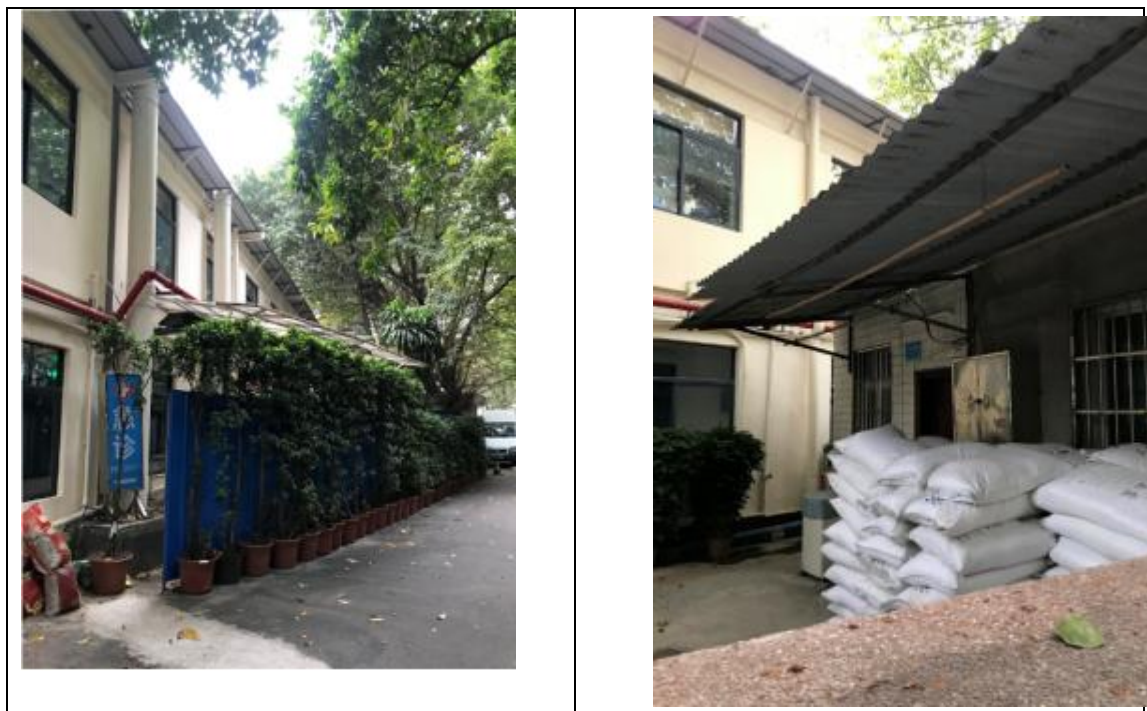
图 2-4-1 医院现状污水处理站措施
